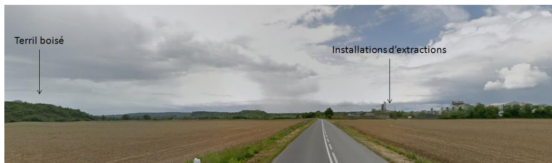
Vue sur les installations de la carrière de la Noubleau à Saint-Varent
